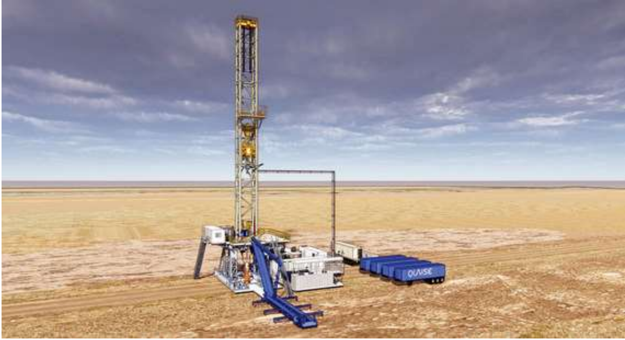
Planta pilot de geotèrmia profunda de Quaise, en construcció. Imatge Hector Vargas, Quaise
