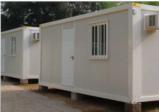
Fig.46: Exemple de modul prefabricat
