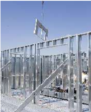
Fig.30: Construcció d'un habitatge amb estructura d'acer.
