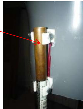
Fig43: Tub de coure aguantat amb les pinces de plàstic/Font pròpia
