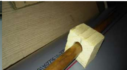
Fig50: Tac de fusta per corregir la direcció/ Font pròpia
